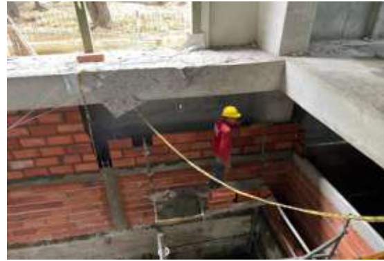
Levantamiento de muro de arcilla
