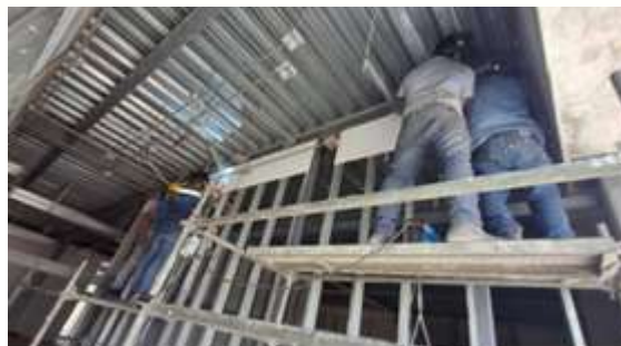
aplicación de soldadura en estructura metálica
