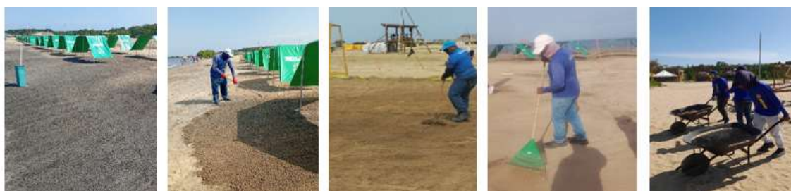
Nivelación de arena
