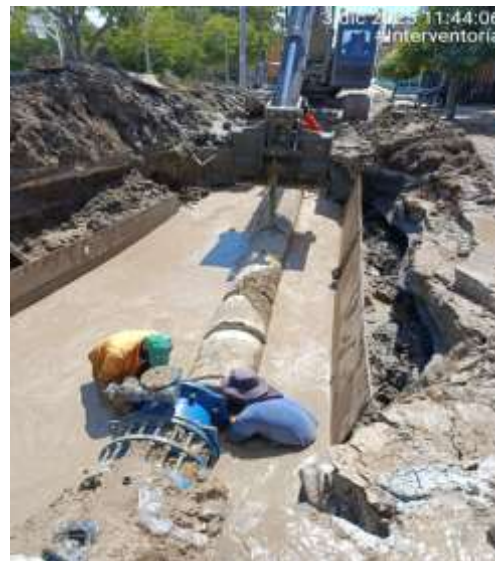
Red matriz No. 05: Instalación de tubería WSP de 20"
