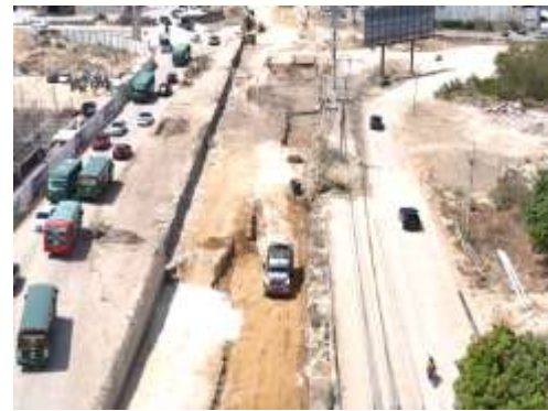
Avance excavaciones deprimido
