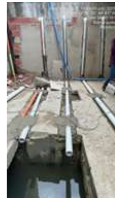
Instalación de tubería en zona nivel -1
