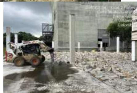
Demolición de estructuras
