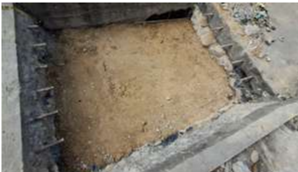
compactación de material sobre la carrera 46
