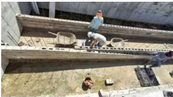
instalación de bloques para muros de escalera en zona de gradería
