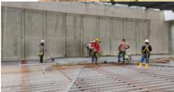
Fundida de losa de entrepiso
