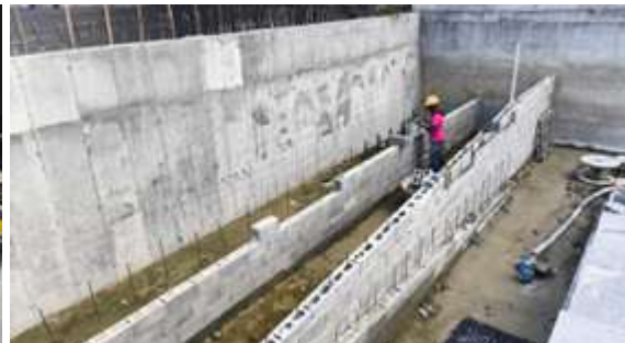
instalación de bloques para escalera en zona de gradas
