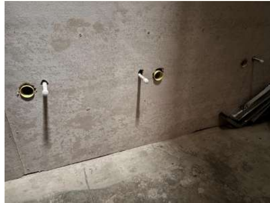
Instalación de tubería de baños lavamanos
