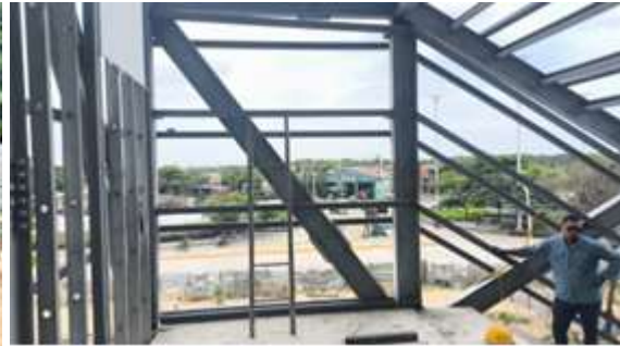
instalación de estructura metálica en escalera
