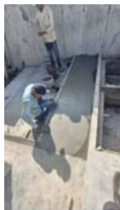
Vaciado de concreto para pasos de escalera
