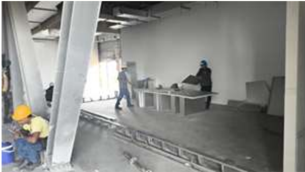
instalación de ductería de aires acondicionados
