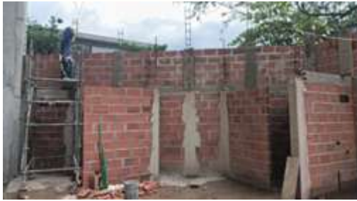
Vaciado de concreto en columnetas en zona de carga
