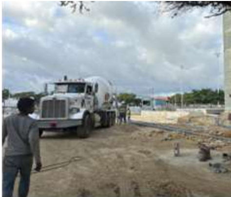
Instalación de concreto para cárcamo en parqueadero
