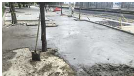
vaciado de concreto para base de anden sobre la carrera 46
