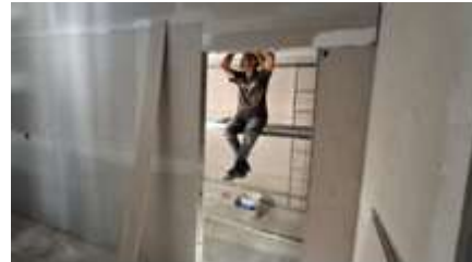
Aplicación de estuco plástico en piso 5
