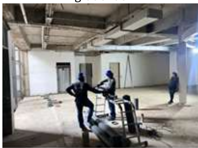
Instalación de tubería de aires acondicionados nivel -1
