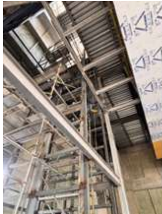
Aplicación de puntos de soldadura en estructura metálica
