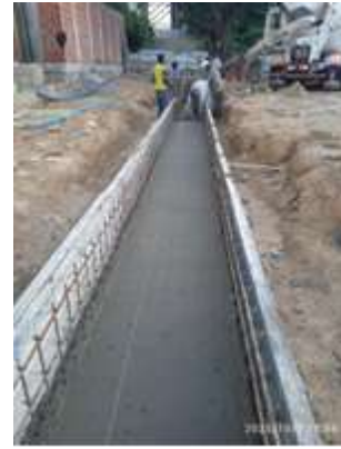
Vaciado de concreto para fondo de cárcamo en parqueadero
