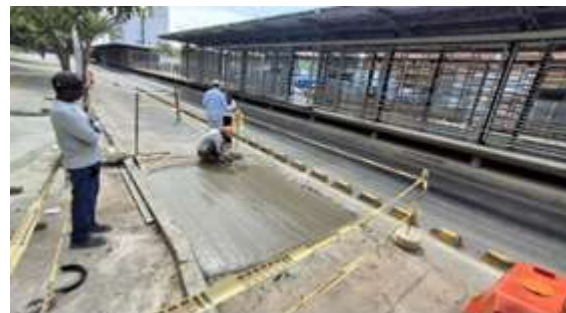
fundida de placa sobre carrera 46
