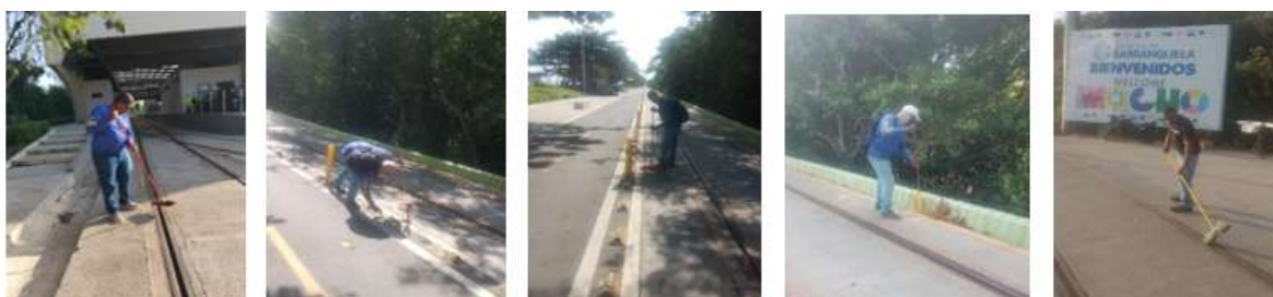
Limpieza de rieles
