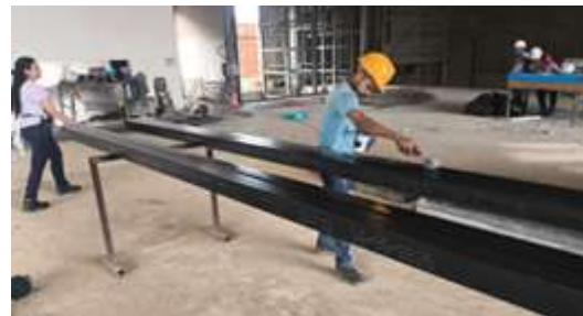
Aplicación de anticorrosivo
