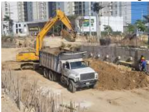
Avance excavaciones deprimido
