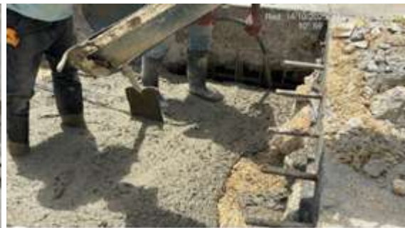
vaciado de concreto para solado y muro de boxculvert carrera 46
