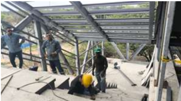
soldadura de estructura de escalera
