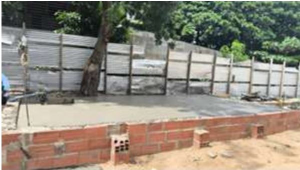
vaciado de concreto en tapa de tanque nivel freático
