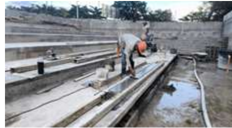
Vaciado de concreto para zona de gradas
