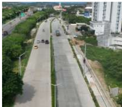
Avance construcción espacio público
