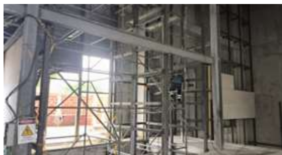
instalación de estructura metálica área de ascensor
