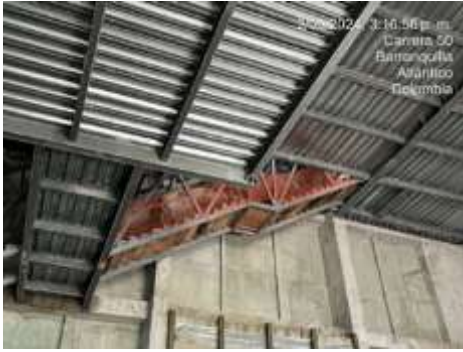
adecuación de acceso a niveles superiores
