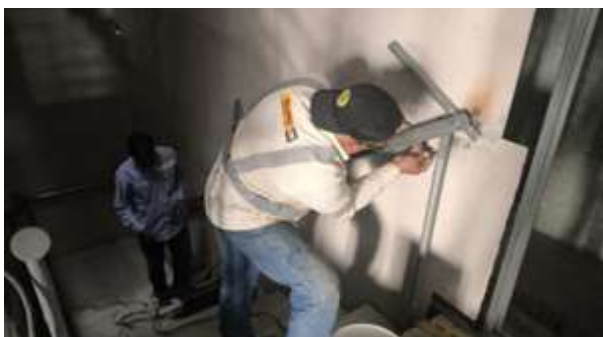
instalación de barandas de escalera interna
