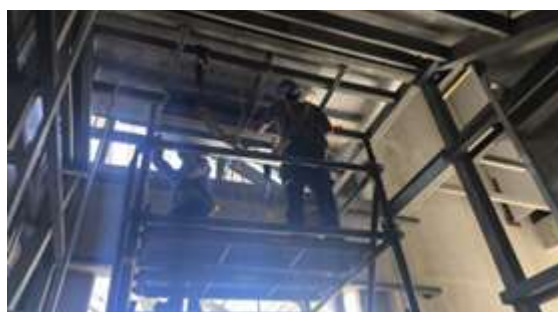
ajuste de estructura metálica en escalera de emergencia
