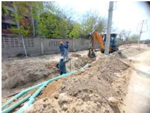
Avance instalación de tubería
