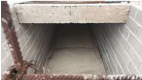
Vaciado de concreto para base de nivelación bajo graderías
