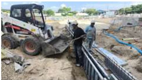
Vaciado de concreto para cárcamo en parqueadero
