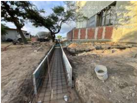
Instalación de acero para cárcamo en parqueadero
