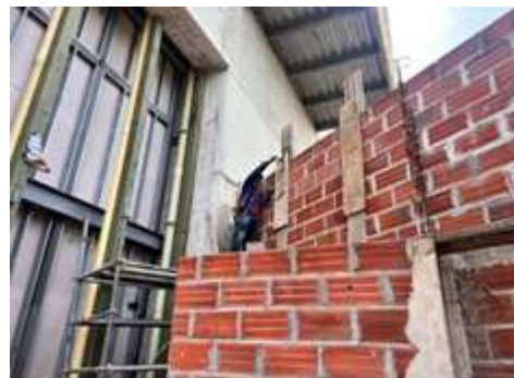
Vaciado de concreto para columnetas en zona de carga
