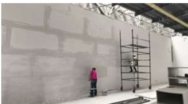
aplicación de estuco plástico en nivel 6
