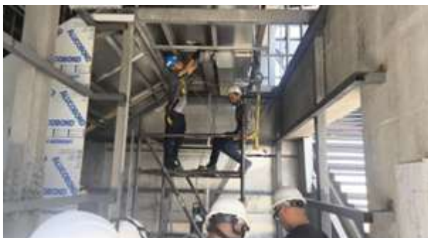
instalación de equipos fan coil
