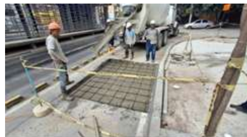
Instalación de acero para placa carrera 46
