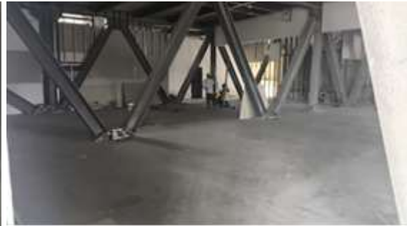
instalación de estructura de superboard nivel 5
