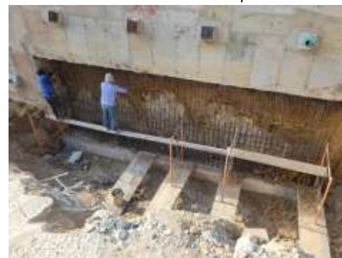
Avance construcción muros deprimido
