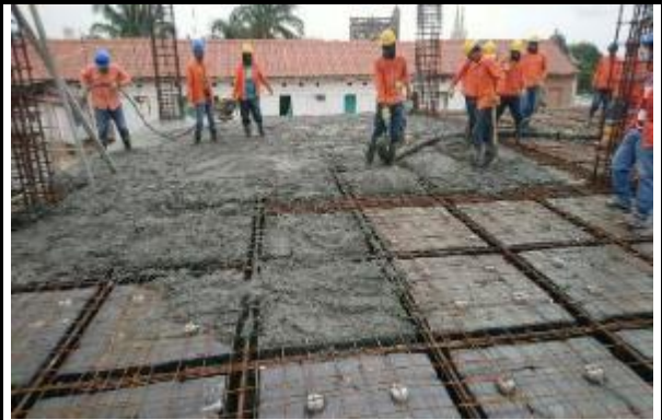
Vaciado de una sección de la losa del tercer piso desde eje GHI3 hasta GHI6
