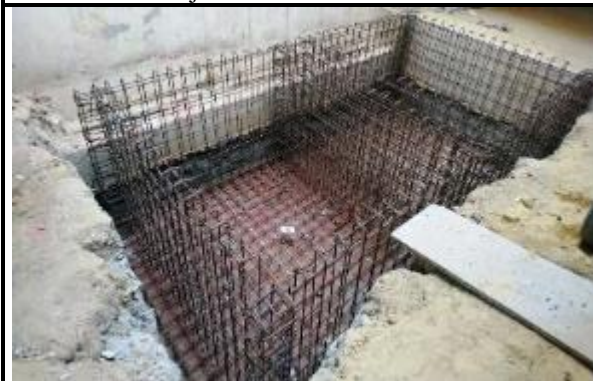
Instalación del acero de refuerzo en el foso del ascensor del eje 7.
