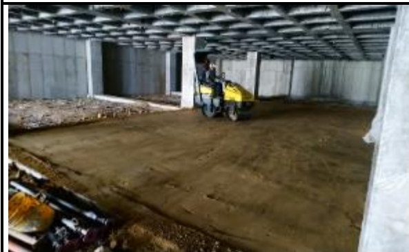
Se avanza en el relleno del semisótano del proyecto.
