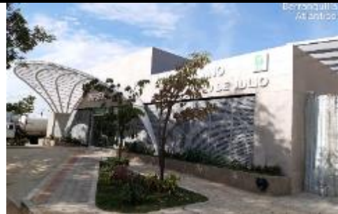
Vista general del acceso a urgencias del proyecto.
