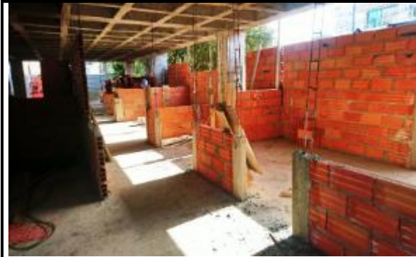
Se continúa levante de muros en bloques Samo sobre placa de primer nivel nueva área entre los ejes 1A-3A hasta 1D- 3D sector de la escalera con eje 3C
