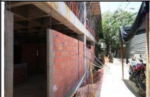
Se Continúa levante de muros en bloques Samo sobre placa de primer nivel, área entre los ejes 1A-3A hasta 1D- 3D
