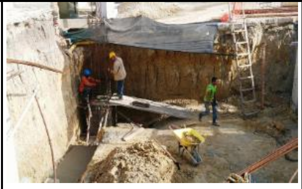
Se funde pedestal de columna en eje 7A
