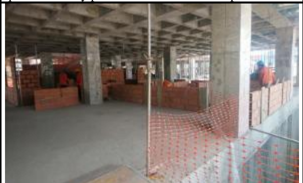
Se continúa levante de muros en bloques Samo sobre placa de primer nivel nueva área entre los ejes 1A-3A hasta 1D- 3D sector de la escalera con eje 3C.
