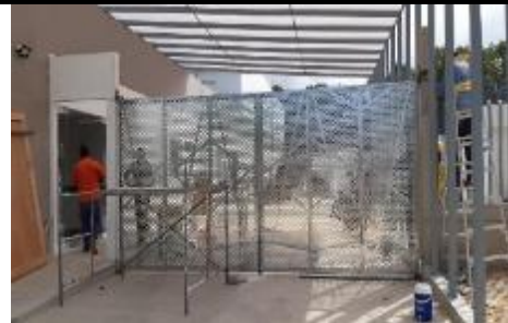
Instalación de puertas de acceso ambulancias y servicios del proyecto.
