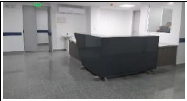
Instalación de muebles en el área de enfermería de observación de urgencias.
