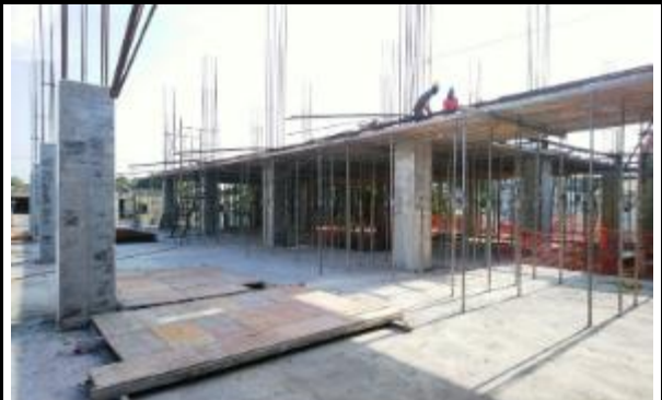
Se continúa la postura de encofrado horizontal y la postura de los aceros para hechura de placa de entrepiso tercer nivel desde los ejes 1D-3D hasta 1A-3A
