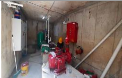
Instalación de las bombas de los sistemas hidrosanitarios.
