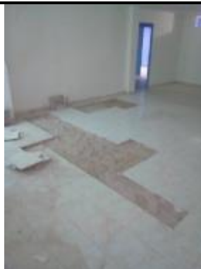
Retiro de baldosas en mal estado.
