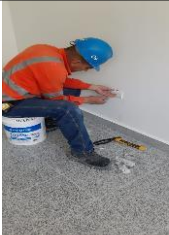
Instalación de lámparas y toma en el proyecto.
