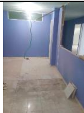
Retiro de baldosas en mal estado.
