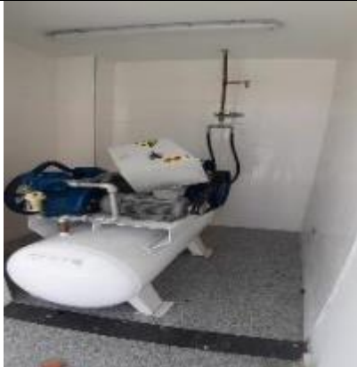
Instalación de compresor
