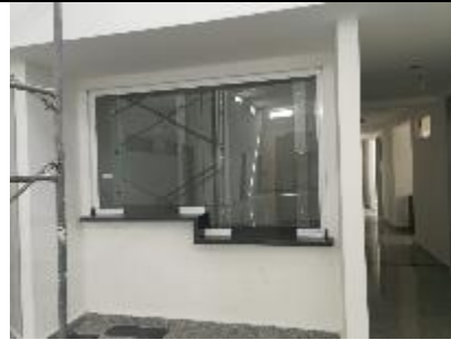
Vista general de la sala de espera y de la caja e información.
