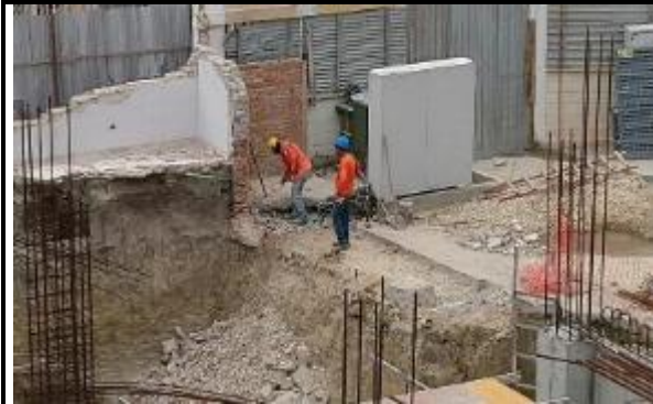
Perfilada de la excavación del sector donde se encontraban los contadores y el transformador para comenzar con los trabajos propios de cimentación, muros de contención y columnas faltantes en el sector de los ejes A-7.
