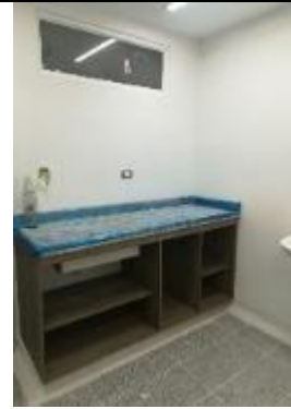
Instalación de muebles en los diferentes espacios del proyecto.
