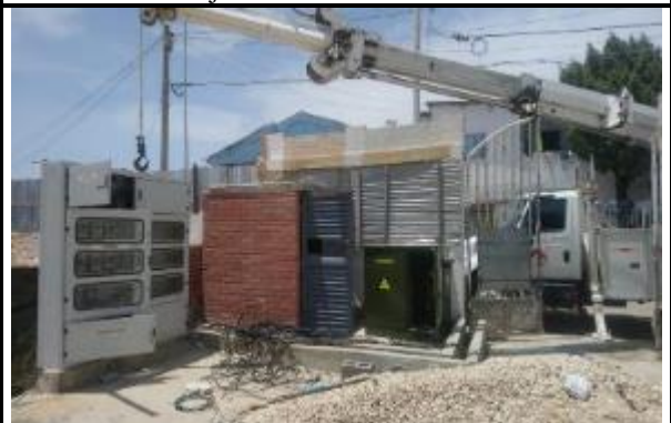
Se realizó el traslado del transformador y de los contadores para proceder con la excavación del sector que hace falta y poder culminar la losa del primer nivel.
