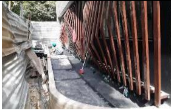
Impermeabilización de las jardineras del acceso a consulta externa e instalación de elemento decorativos de fachada.
