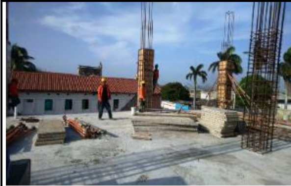
Se desencofrada de columnas sobre placa del tercer nivel en los ejes 3I-4I-5I 6I-6H-7I
