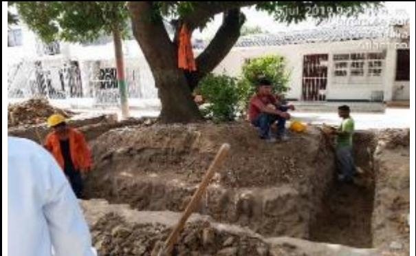
Excavación para el contenedor de raíces del árbol de mango que quedará por el sector de acceso a la consulta externa.
