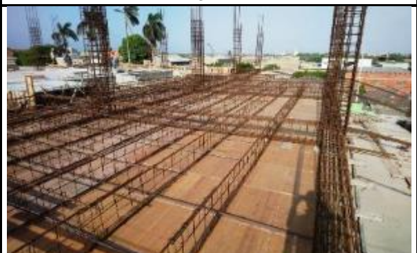
Se continúa la encofrada y postura de los aceros sobre el tercer nivel desde los ejes 3E-7E hasta 3G-6G.
