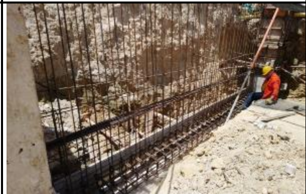
Instalación del acero de refuerzo del muro de contención.
