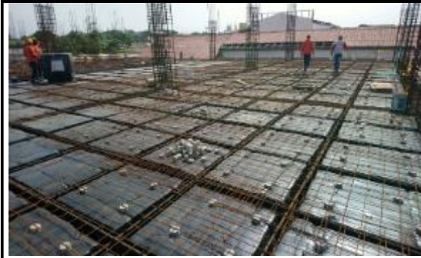
Se continúa con la instalación de casetones de icopor sobre el encofrado horizontal y la instalación de aceros de refuerzo en la losa del tercer nivel desde los ejes 3I-6I hasta 3G-6G.
