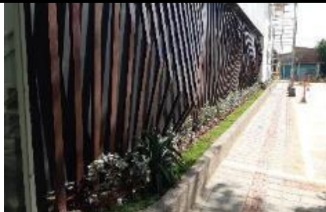
Vista de la fachada Sur del proyecto (Acceso al área de Consulta Externa).
