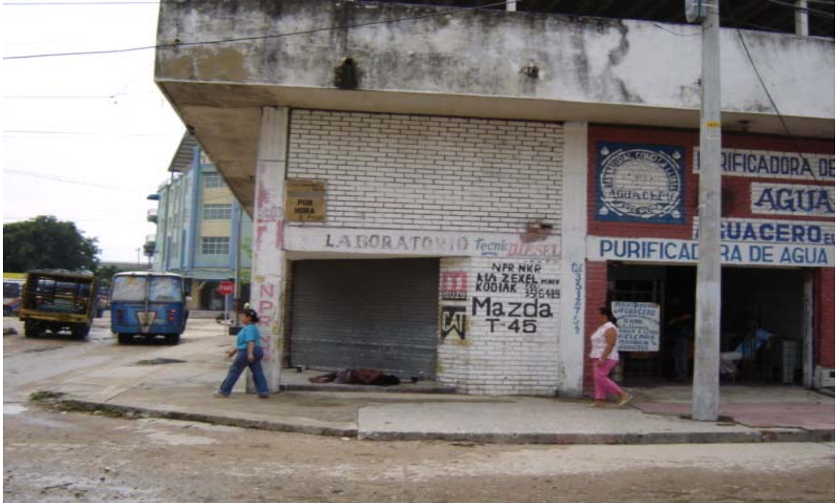
Foto Edificio Cardona Niebles ( Proyecto Plaza de la Concordia)
